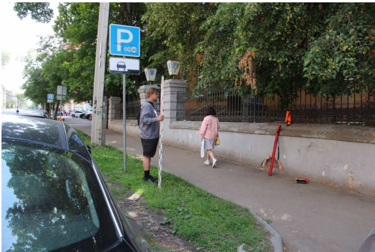
Илл. 34. Общий вид земельного участка, отведенного для расположения объекта: «Магистральная теплотрасса» кад. 52:18:0000000:1027 на участке: от ТК- 501-9 у д.48 по ул. Грузинская до ТК-501-11 у д.33 по ул. Октябрьская; «Сооружение Магистральная теплотрасса отопления» кад. 52: 18:0000000:6677 на участке: от ТК-501-11 у д.33 по ул. Октябрьская до т в 4 м на СВ от СВ угла д.9а по ул. Ошарская. Точка фотофиксации 2. Вид с севера.
