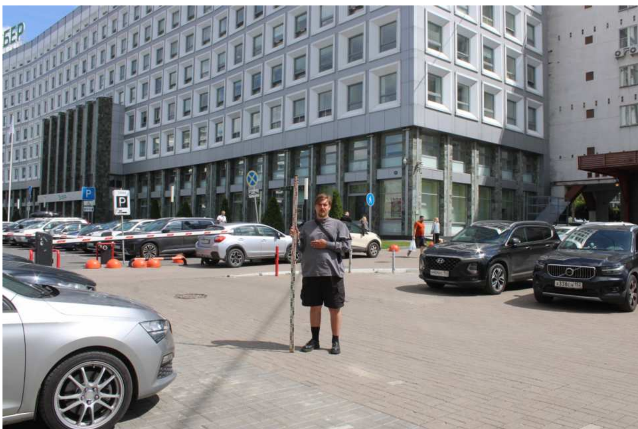
Илл.45. Общий вид земельных участков, отведенного для расположения объекта: «Магистральная теплотрасса» кад. 52:18:0000000:1027 на участке: от ТК- 501-9 у д.48 по ул. Грузинская до ТК-501-11 у д.33 по ул. Октябрьская; «Сооружение Магистральная теплотрасса отопления» кад. 52: 18:0000000:6677 на участке: от ТК-501-11 у д.33 по ул. Октябрьская до т в 4 м на СВ от СВ угла д.9а по ул. Ошарская. Точка фотофиксации 5. Вид с востока.
