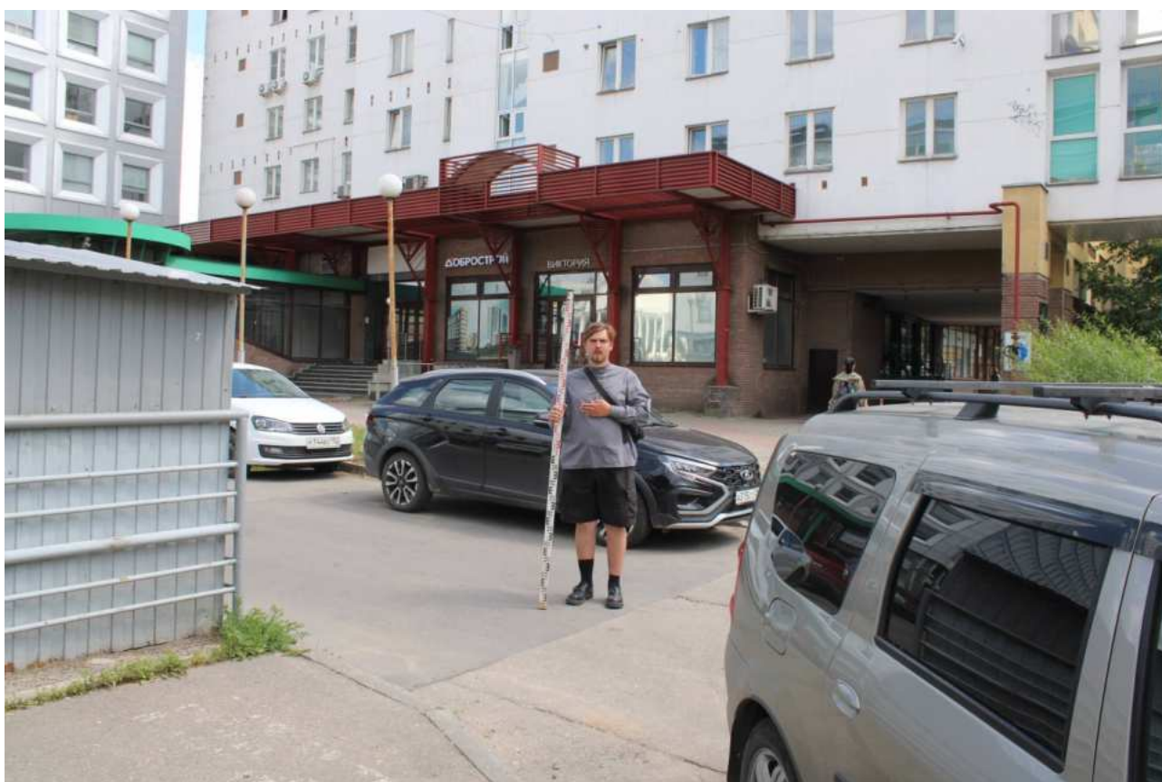
Илл.41. Общий вид земельных участков, отведенного для расположения объекта: «Магистральная теплотрасса» кад. 52:18:0000000:1027 на участке: от ТК- 501-9 у д.48 по ул. Грузинская до ТК-501-11 у д.33 по ул. Октябрьская; «Сооружение Магистральная теплотрасса отопления» кад. 52: 18:0000000:6677 на участке: от ТК-501-11 у д.33 по ул. Октябрьская до т в 4 м на СВ от СВ угла д.9а по ул. Ошарская. Точка фотофиксации 4. Вид с востока.
